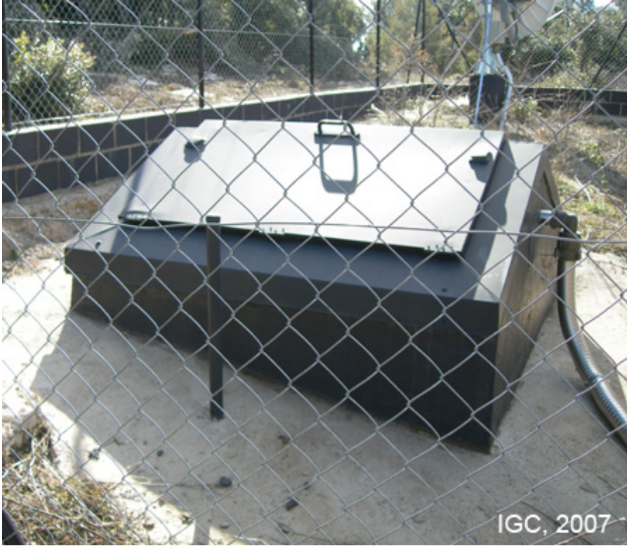
Detall de la coberta del pou sísmic en superfície.
