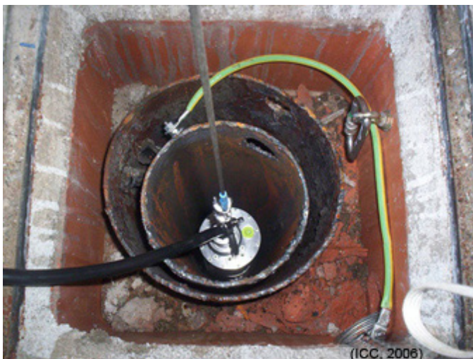
Sensor: Sismòmetre situat a 32 m de fondària a l'interior del forat de sondeig entubat (bore-hole). Instal·lació del sensor.
