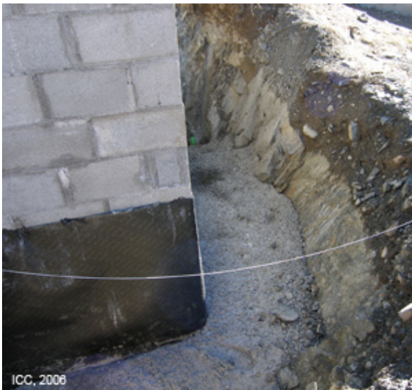
Condicions geològiques de l'emplaçament: Aflorament rocós pelites, gresos i grauvaques, Paleozoic).
