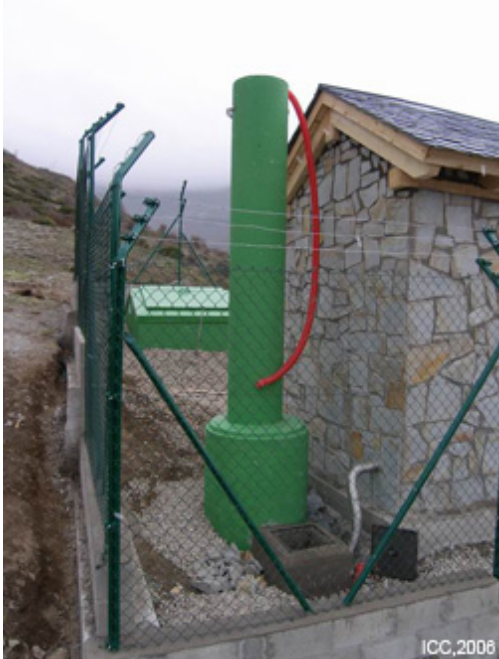
Vista en detall del pilar geodèsic situat al darrera de la caseta instrumental i la tanca de seguretat.
