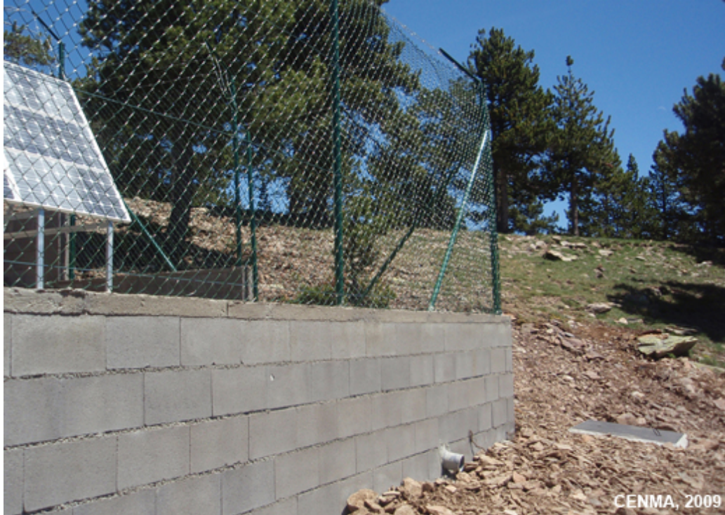
Detall de la tanca de seguretat amb una arqueta de registre del cablejat de la pressa de terra
